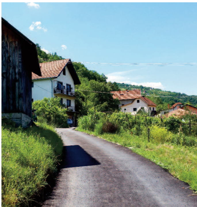
Асфалтирање - Бањски Чамац
